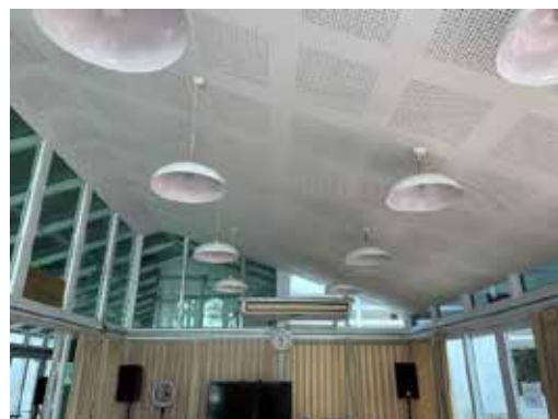
จัดทำฝ้าใต้หลังคา ระงับความร้อน
